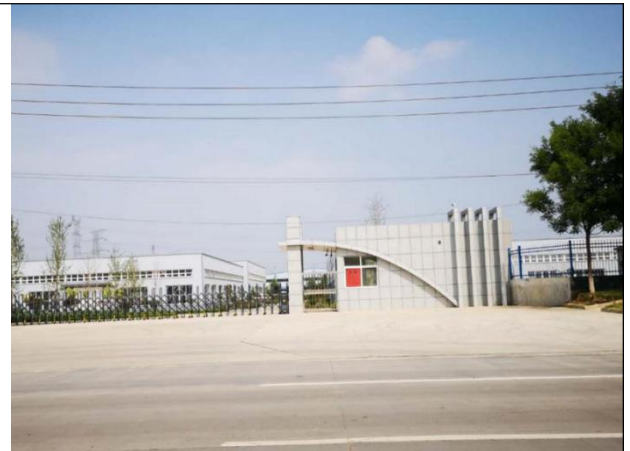
租赁厂区西侧其他工业厂房
